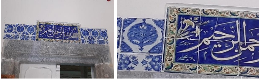
Resim 21. Caminin Batı Giriş Kapısı Üzerindeki Çiniler
