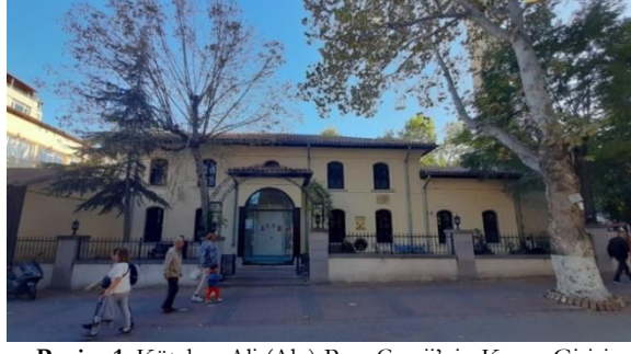
Resim 1. Kütahya Ali (Alo) Paşa Camii'nin Kuzey Girişi
