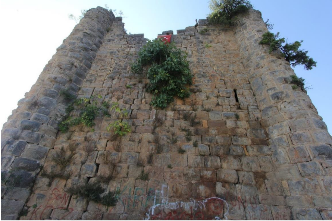
Foto 10. Doğu Cephe – Detay
