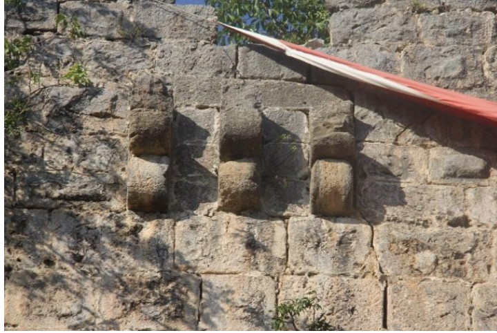
Foto 12. Güney Cephe - Üçlü Konsol (Çıkma)
