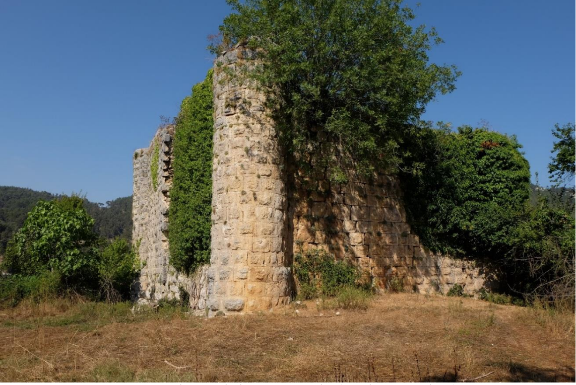
Foto 22. Sinap Kalesi - Güney Cephe (Çandır Köyü Civarı)
