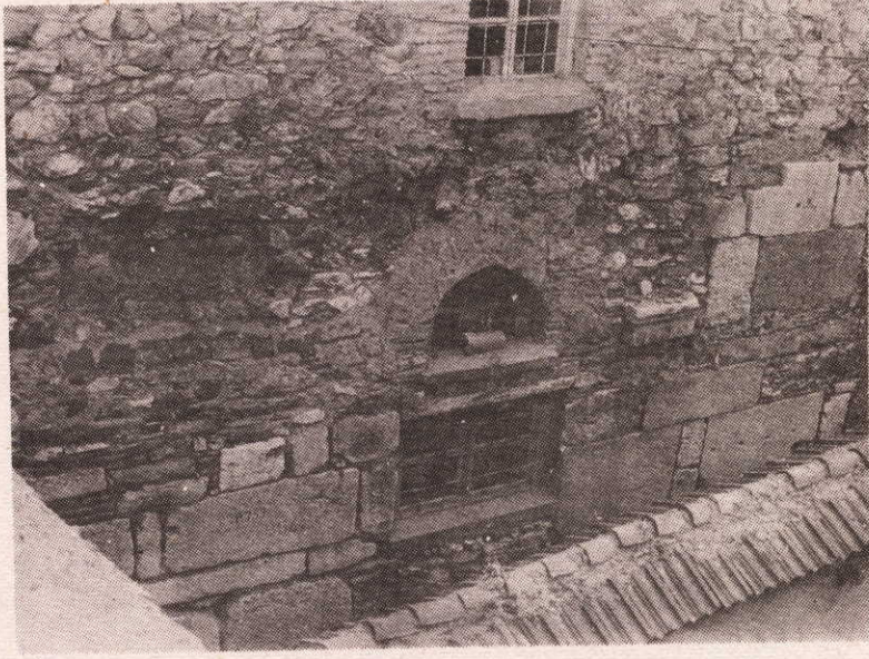
Resim - 1 Kuzey Cephesi
