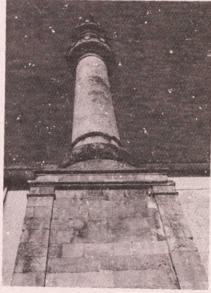
Resim - 7 Atik İbrahim Paşa Camisinin Minaresi
